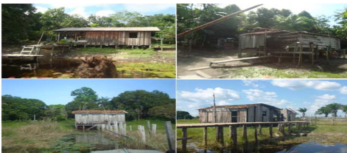
Figura 5 - Residências no Projeto de Assentamento Gleba Majari I
