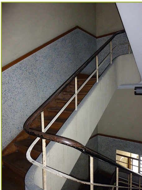
Figura 11 Escadas e patamar do 3º andar. Fotografia da autora, 2015.
